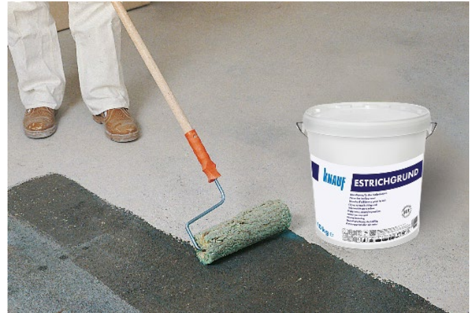
Figure 13: Apply Estrichgrund screed primer
