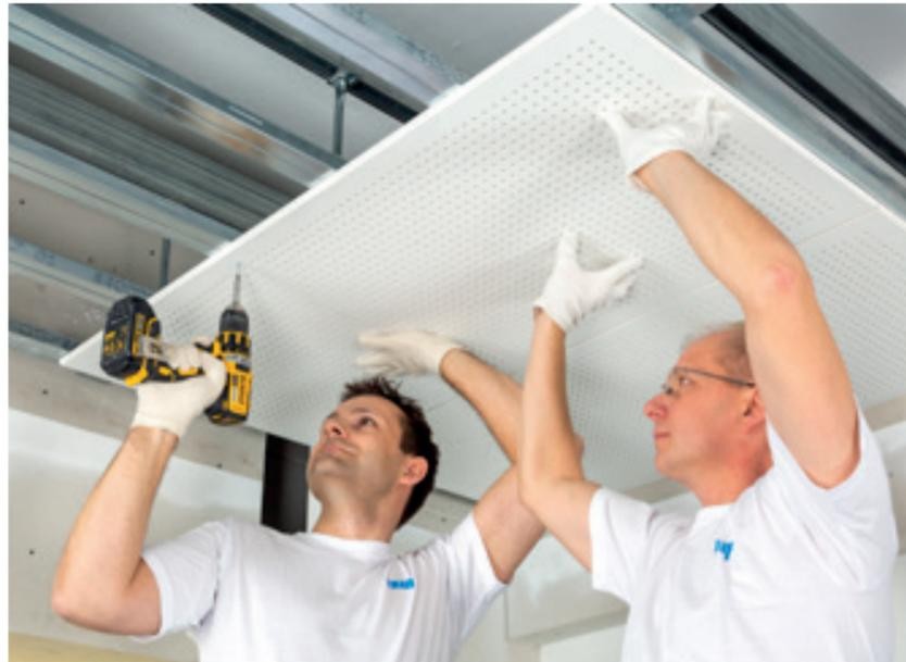
Passgenaue Verlegung durch umlaufende Faskante.
