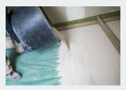
Bei der Verarbeitung von Knauf Schüttungen einen geeignete Abziehlehren verwenden. Diese hinterlassen keine Vertiefungen oder Lücken in der abgezogenen Schüttung
