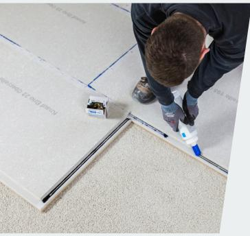
Die Verlegung der Brio-Elemente erfolgt bei Ausgleich mit loser Schüttung vom verlegten Boden aus, damit die Schüttung nicht betreten werden muss
