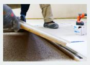
Der obere Falz wird durch das Körpergewicht auf den unteren gepresst ...
