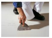
Plattenstöße mit Knauf Uniflott schließen
