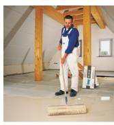
Mit der Stachelwalze wird eine besonders ebene Oberfläche erzielt
