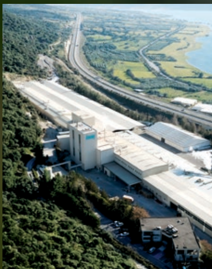
Το εργοστάσιο παραγωγής γυψοσανίδων στην Αμφιλοχία εξοικονομεί ενέργεια και αυξάνει την ενεργειακή απόδοση.
