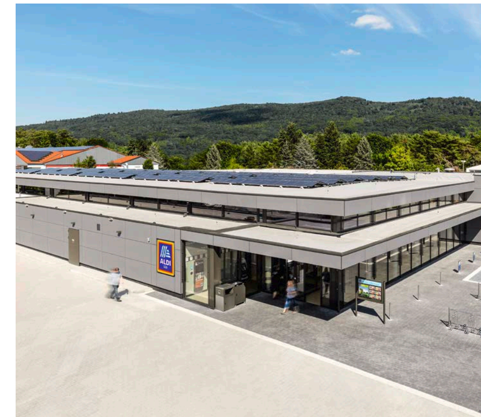
Wir haben die Dächer der ALDI SÜD Filialen sowie unserer Logistikzentren mit Fotovoltaikanlagen ausgestattet, um Solarenergie zu gewinnen.
