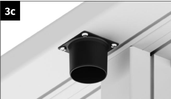
Verschrauben Sie den Ablaufstutzen mit den vier Bohrschrauben 4,8x13 mm. Auch hier empfehlen wir, vorzubohren.
