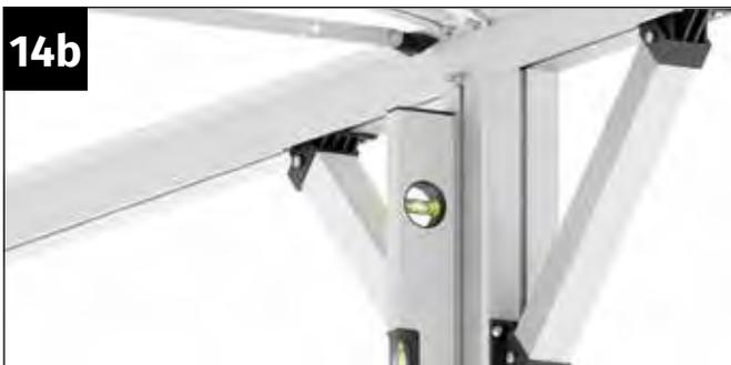
Nehmen Sie eine Wasserwaage und richten Sie den Pfosten exakt lotrecht aus. Nehmen Sie sich dafür entsprechend Zeit - je genauer Sie hier arbeiten, umso stabiler steht im Anschluss die gesamte Konstruktion.
