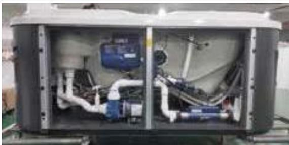
Öffne die Steuerung und führe das Netzkabel durch die seitliche Öffnung. Schließe das Netzkabel (**Empfehlung:** Aderquerschnitt 2,5 mm<sup>2</sup>) an (siehe Anschlussplan der Steuerung).
