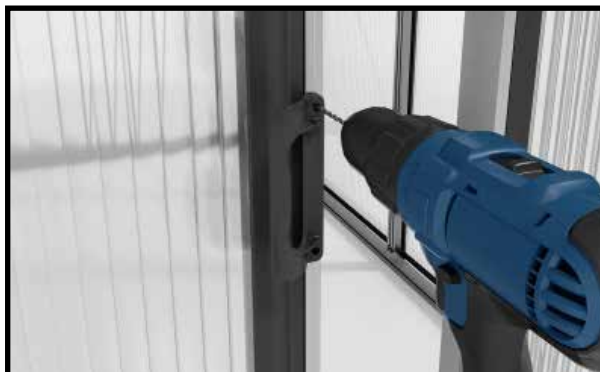
Začnite z zunanjimi vratnimi ročaji. Odprtine izvrtajte s svedrom premera 4 mm.
