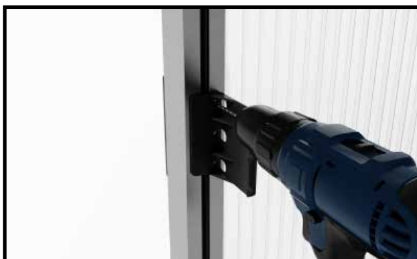
Sedaj namestite notranje vratne ročaje. Odprtine izvrtajte s svedrom premera 4 mm.
