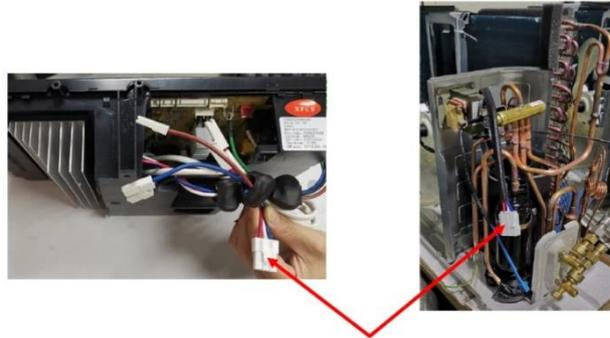
2) Bitte überprüfen Sie die Drähte des Kompressor Anschlusses, da U, V, W korrekt angeschlossen sind, entsprechend und fest oder nicht, sie sollten mit der Leiterplatte übereinstimmen, wenn Sie vermuten, dass sie es nicht sind, versuchen Sie bitte, sie entsprechend der Farbe der Leiterplattendrähte zu korrigieren.
