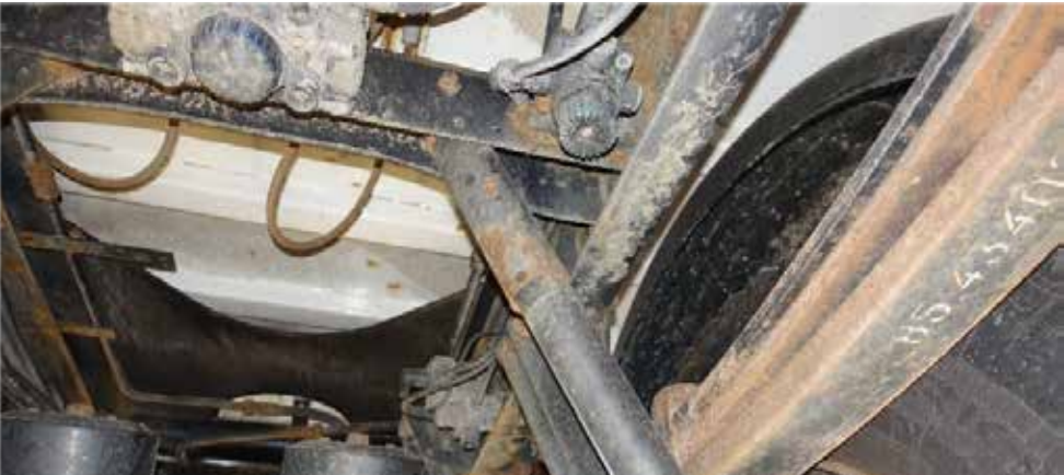
✓ Leichte Korrosionsmerkmale Kipper
