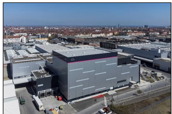
Aufbau der Produktionshalle für die Batterie-Großserie
