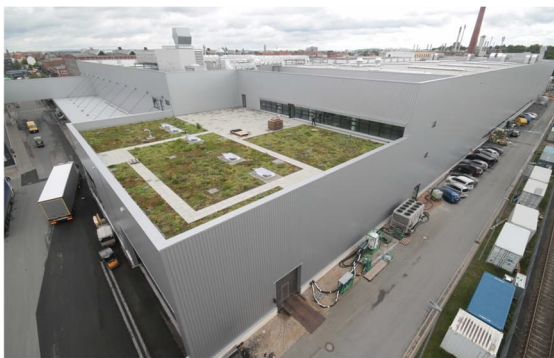
Dachbegrünung auf der neuen Fertigungshalle
